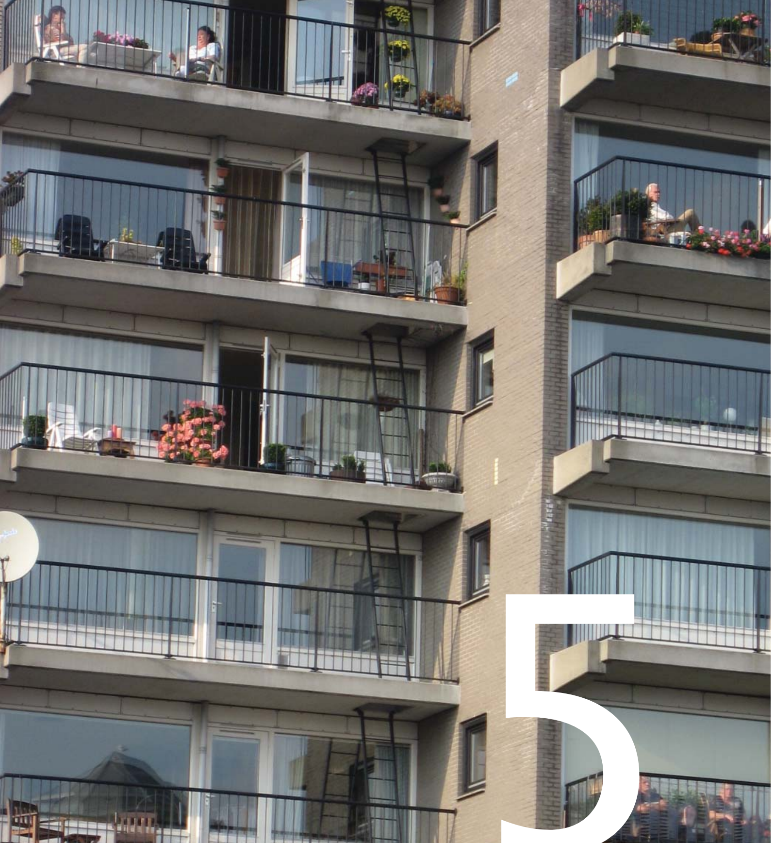
Groningen, Brinkflats [40 m]
