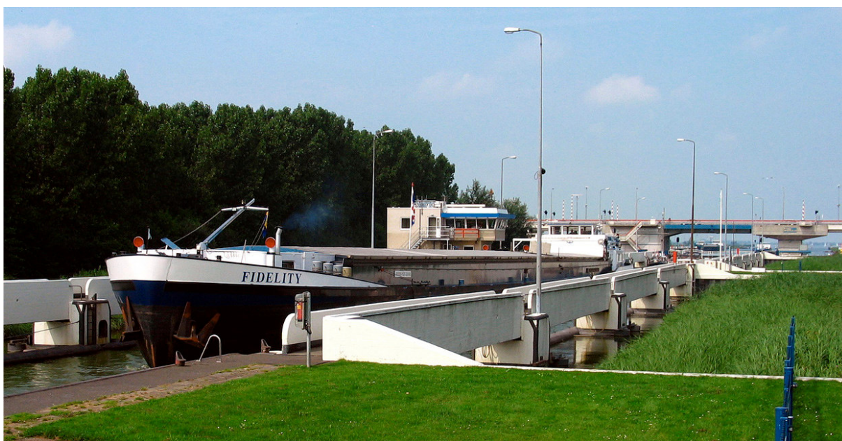
Figuur 5.1 - Prinses Margrietsluis te Lemmer
