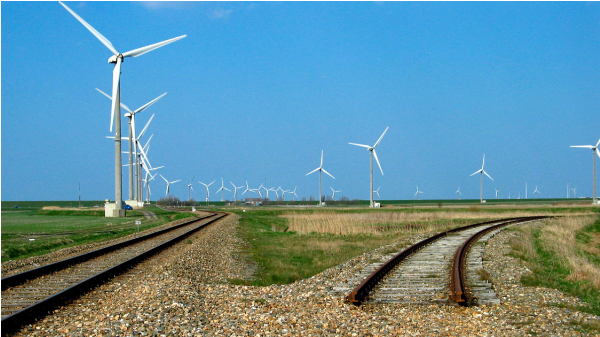
Figuur 8.13 - De gedeeltelijk aangelegde sporendriehoek voor de oostelijke stamspoorlijn in de Eemshaven.
