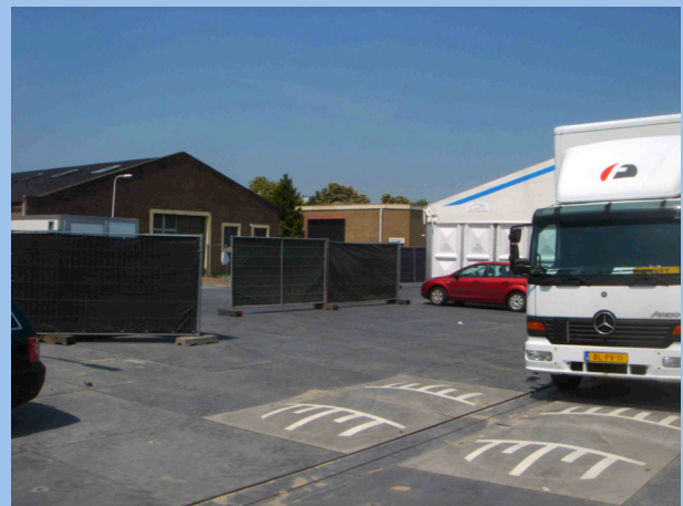
Foto 10: De gemeente investeert in de openbare ruimte, waaronder de herinrichting van het plein aan de kade met betonplaten, passend bij het industriële karakter. De ondergrond is sterk genoeg om ontwikkelingen te faciliteren.
