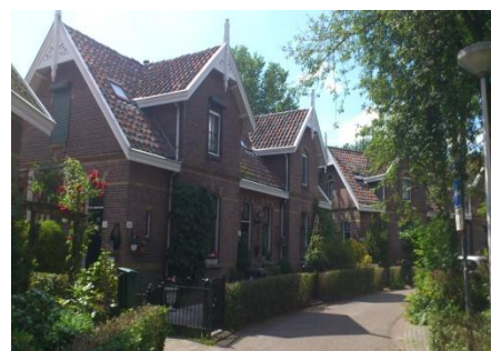
Figuur 16: woningen bouwjaar ca. 1880, eigen foto
