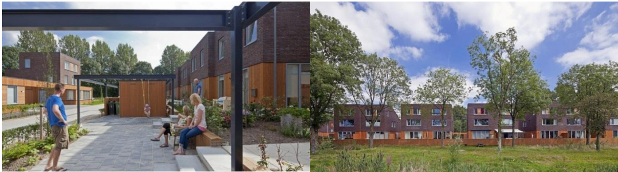
Figuur 8.3 Foto's Achter de Reijdijk (Pegasusstraat) Bron KAW, 2010
