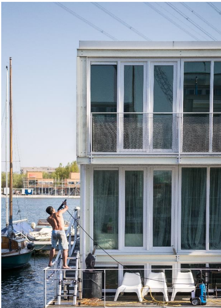
Figuur 18: Zelfgemaakte foto. Het schoonspuiten van exterieur met hogedrukspuit.
