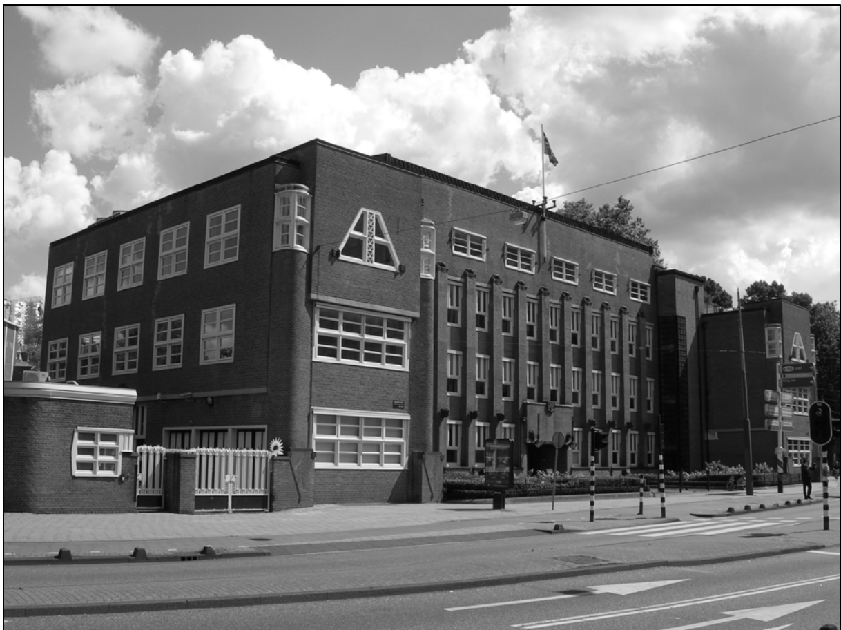
Afbeelding 4.1: Kantoorgebouw met representatieve uitstraling in het centrum van Amsterdam Bron: eigen fotomateriaal
