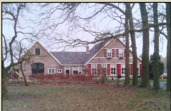
Afbeelding 10: Zomerdijk (Stichting Sallands Erfgoed, 2013)
