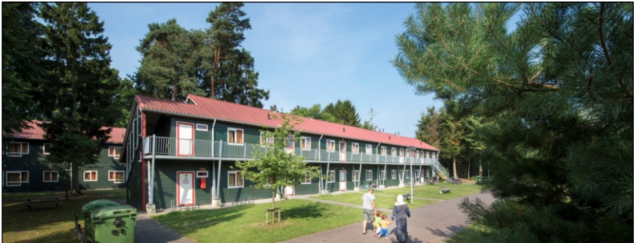
Het asielzoekerscentrum in Oisterwijk. Bron: COA
