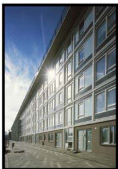
Afbeelding 5.22: Open plint na uitplinten Bron: http://www.nationalerenatieprijs.nl
