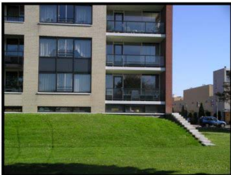
Afbeelding 5.24: Geleidelijke ophoging van het maaiveld in Nieuw Sloten, Amsterdam Eigen bron, 2004
