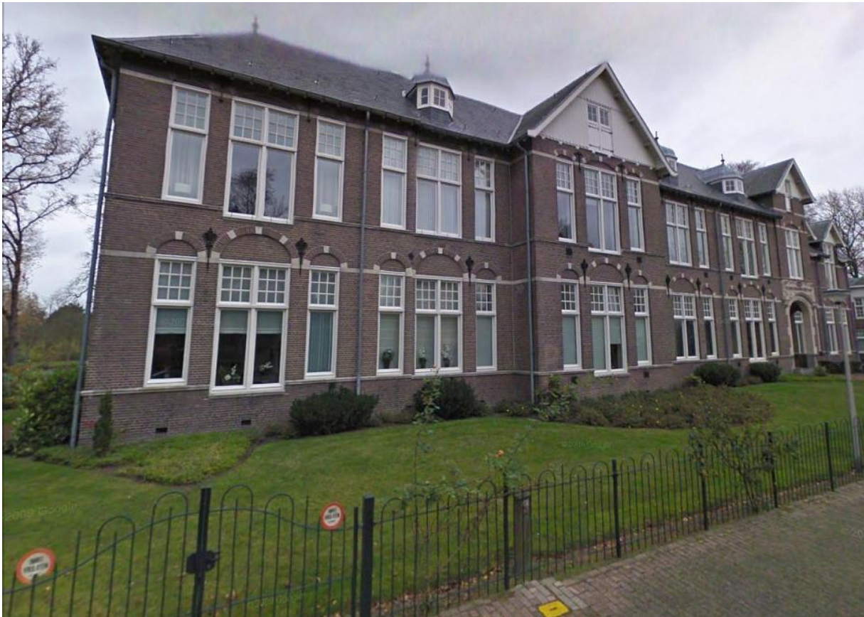
Figuur 5.2 Gemeenschappelijk wonen in erfgoed (Voormalig schoolgebouw, Coevorden)
