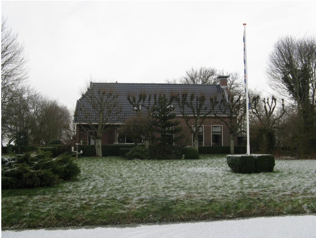
Afbeelding 1. Voormalig agrarisch bedrijfspand dat volledig verbouwd is tot woonboerderij in Marrum
