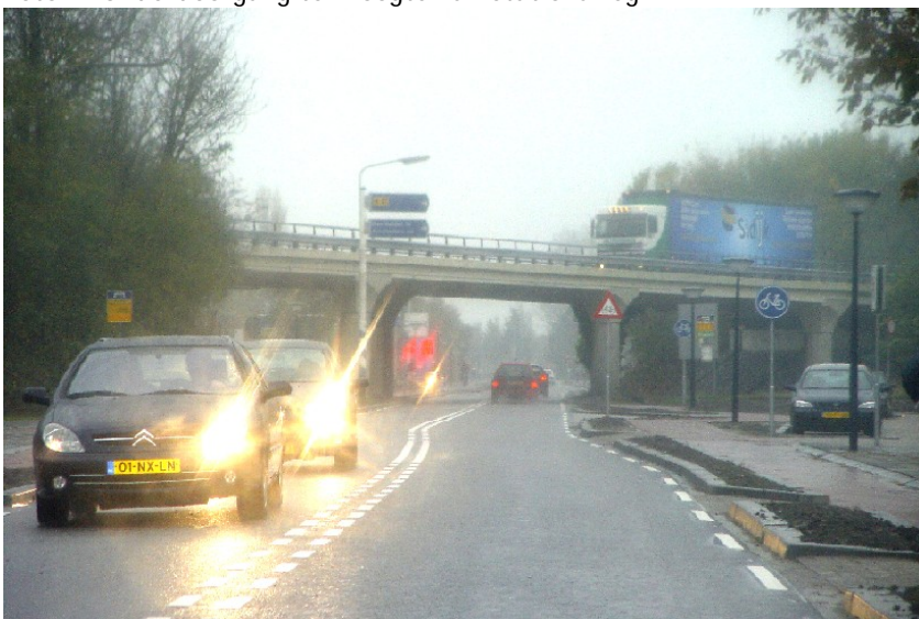
Foto 3: Onderdoorgang ter hoogte van Kimswerderweg (zicht naar zuiden)
