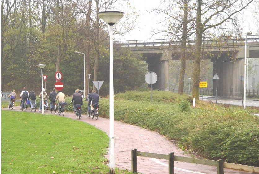
Foto 1: Onderdoorgang ter hoogte van Stationsweg
