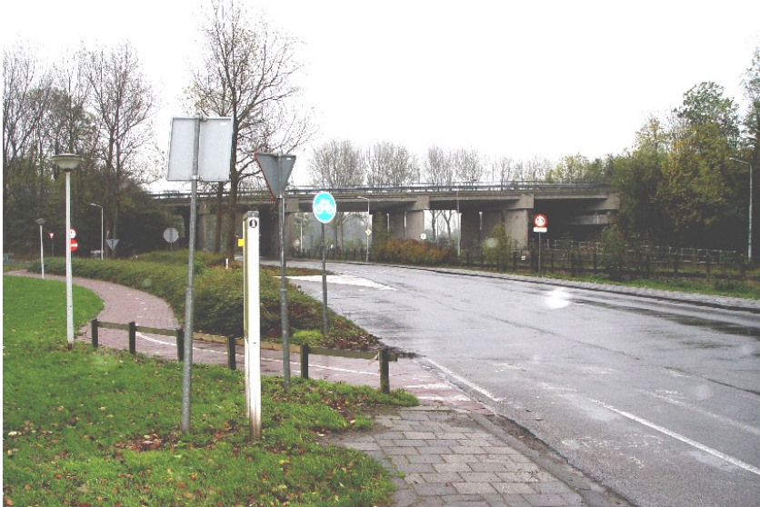
Foto 2: Onderdoorgang ter hoogte van Stationsweg
