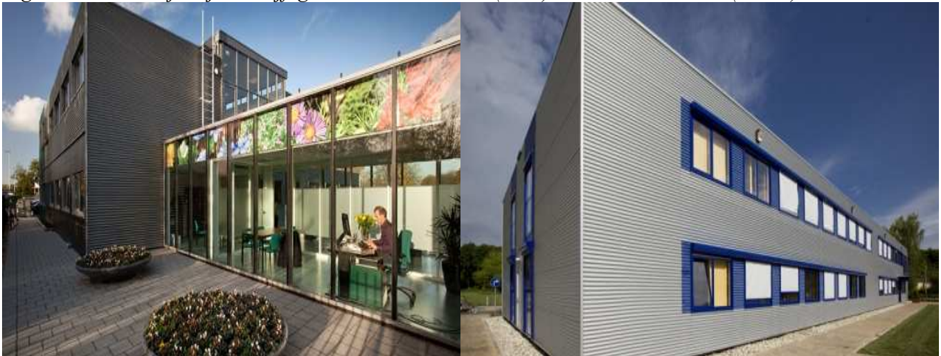
Figuur 1.3: Foto tijdelijk bedrijfsgebouw in Rotterdam (links) en in Middelharnis (rechts).
