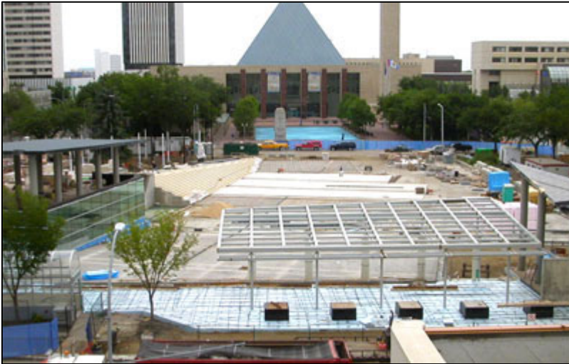
Figuur 17: Het Churchillplein tijdens de bouw (Edmonton, 2005)
