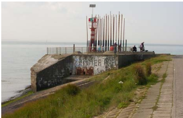
Figuur 3.13 Bunker op het Nollehoofd te Vlissingen
