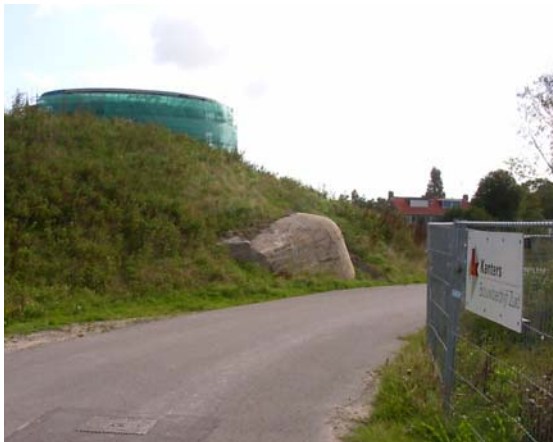
Figuur 3.16 Restanten van geschutsbunkers onder hopen grond nabij nieuwbouw
