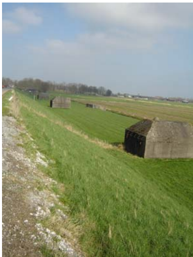
Figuur 4.10 Diefdijk met groepsschuilplaatsen uit 1939
