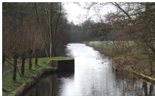
Figuur 4.33 Sluiswerk in Karnemelksloot
