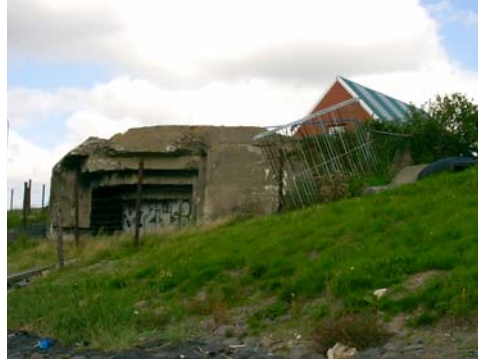
Figuur 3.14 Geschutsbunker in zeedijk
