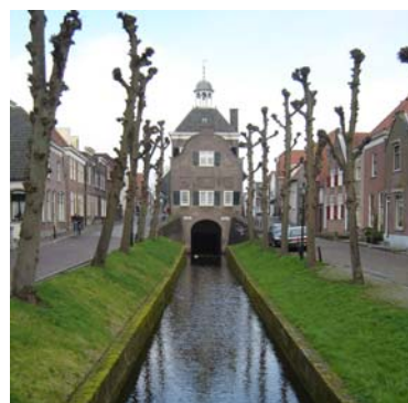
Figuur 4.12 Inundatiesluis onder stadhuis in Nieuwpoort
