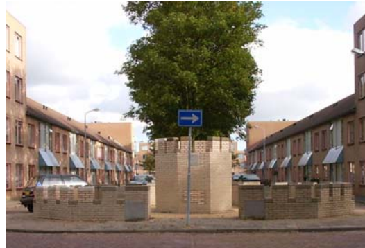
Figuur 3.15 Centraal plein in 'Het Fort'
