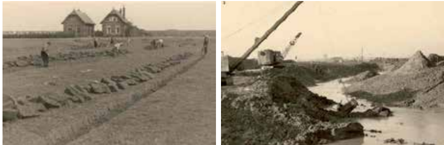
Afb. 50 Voordat men kon beginnen met de aanleg moest eerst het gehele terrein worden gedraineerd, dat was allemaal handwerk zoals op de linker foto is te zien. De rechterfoto laat het werk met de draglines zien. Bron: privéarchief J.Hofman (voormalig hoofd van de begraafplaats Selwerderhof)
