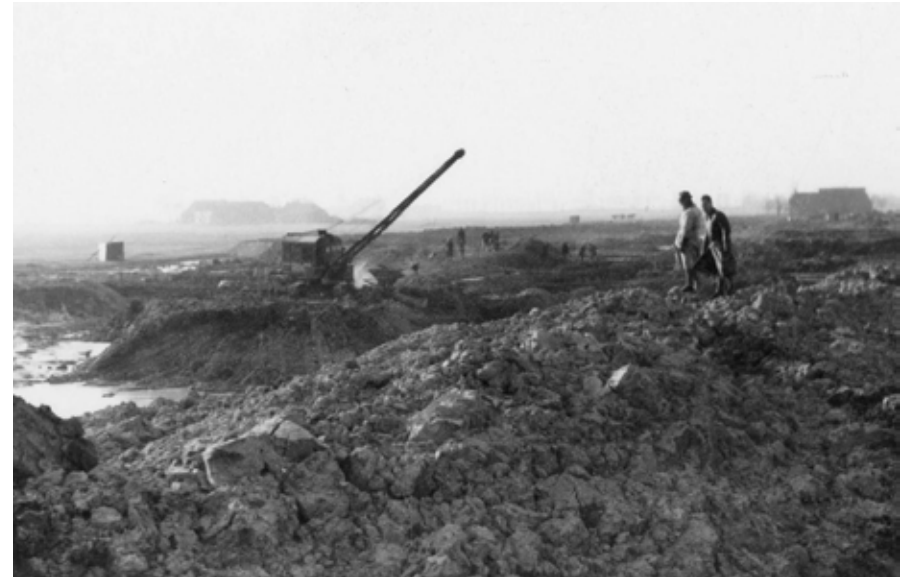
Afb. 51 Voor de aanleg van het Selwerderhof moest eerst veel grondwerk worden verricht. Deze foto is in het begin van de oorlog gemaakt. Bron: www.beeldbank.nl Fotograaf Geert Kuiper, identificatienummer; NL-GnGRA_1785_30870.jpg
