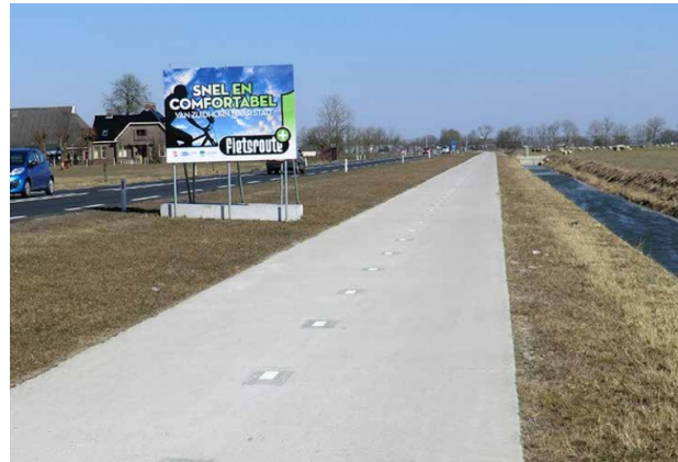
Figuur 6: De gerealiseerde Fietsroute Plus tussen Zuidhorn en Groningen. (Regio Groningen Assen, 2013)
