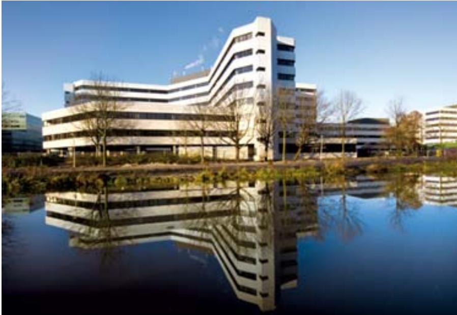
Figuur 8.4 Atlas Arena complex
