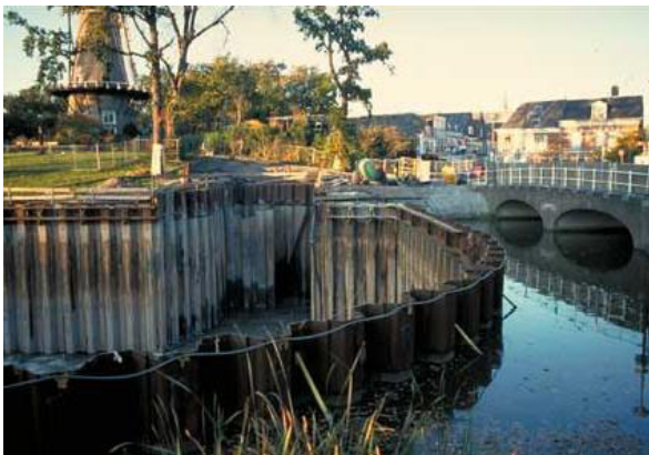
Figuur 5.5 Singelgarage in aanbouw
