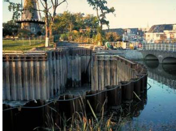
Figuur: Singelgarage in aanbouw
