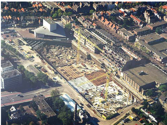
Figuur: Parkeergarage in aanbouw
