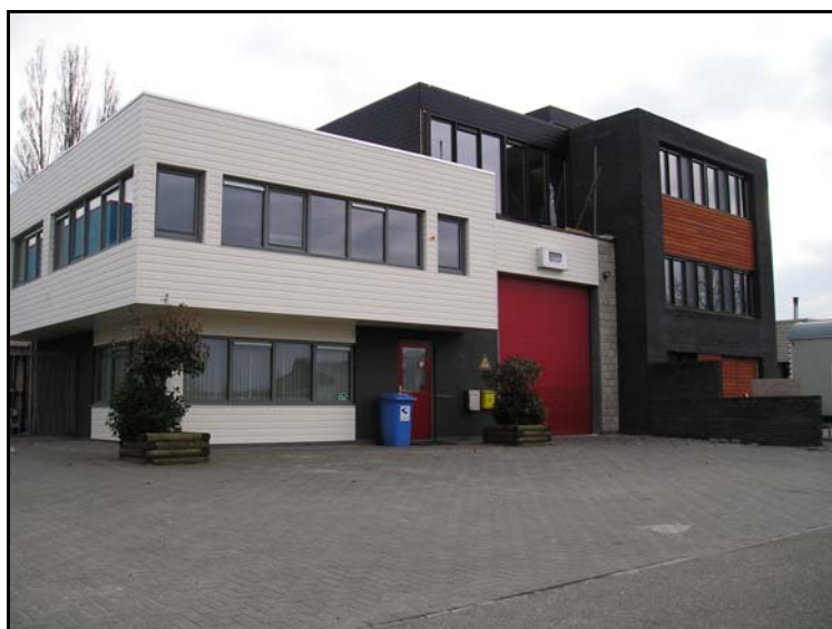
In aanbouw zijnde bedrijfswoning in combinatie met het bedrijf
