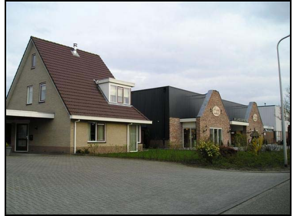
Wonen en werken aan de Eskampweg
