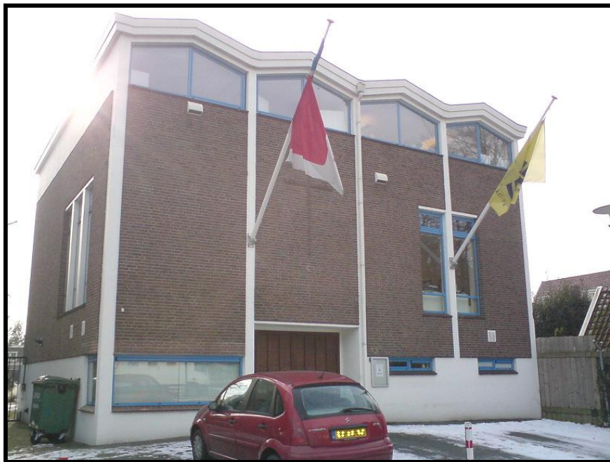
Figuur 17: Achterzijde kerkgebouw bijgebouwde kantoorruimte (Bron: Eigen foto 27-2-2010)
