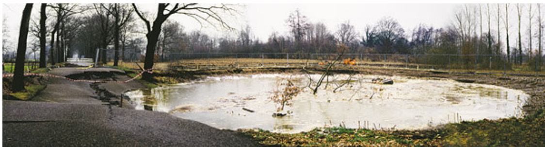
Figuur 2.2: Instorting van een zoutcaverne in Twente (Rijkswaterstaat, 2009)
