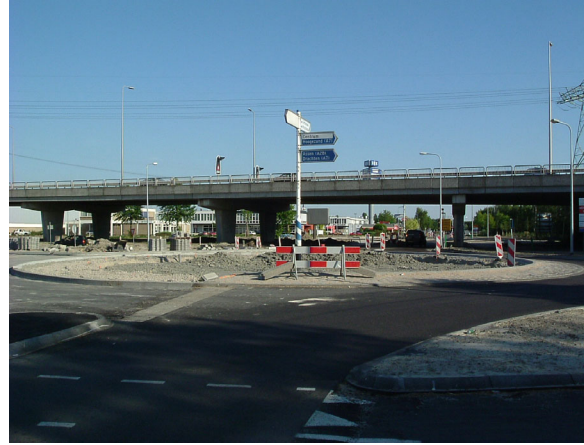
(Figuur 5.10: Aanleg rotonde Bornholmstraat)
