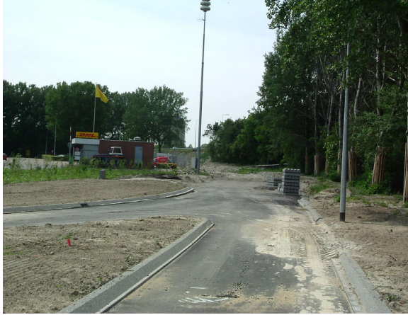
(Figuur 5.9: Aanleg bypass zuidelijke ringweg)
