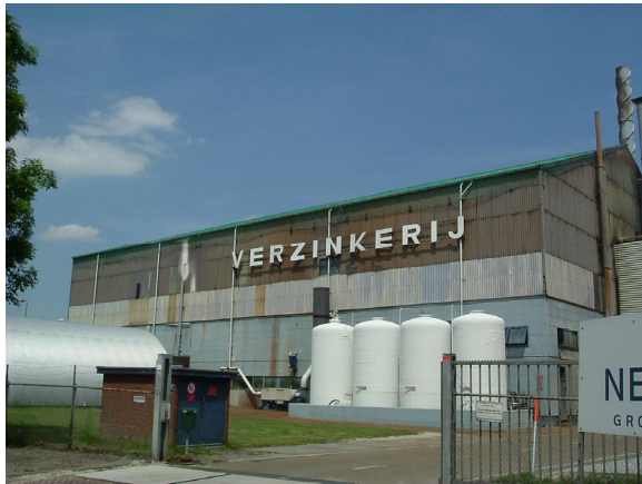
(Figuur 5.3: Vervallen bedrijfspand)
