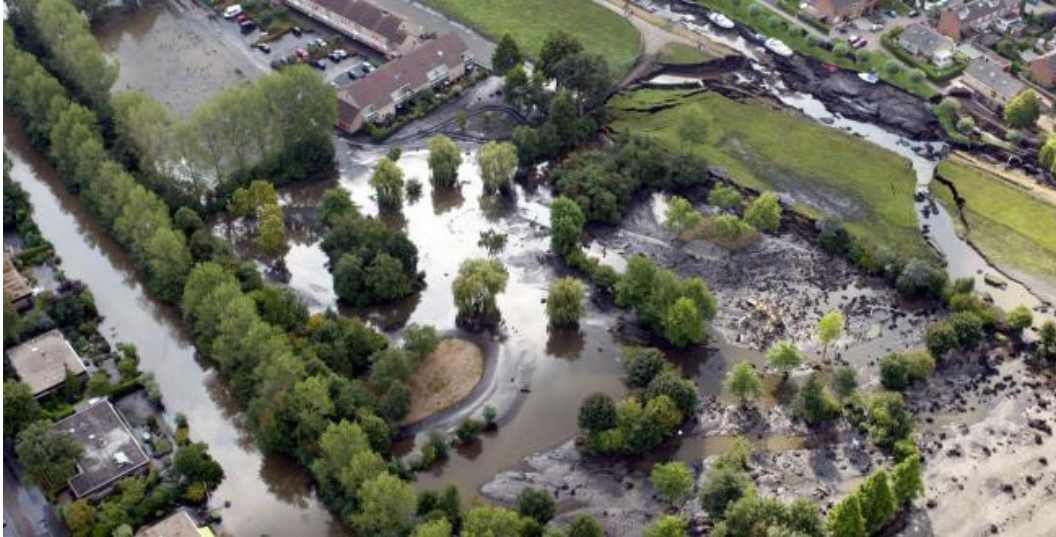
Figuur 3.3 Doorgebroken veendijk in Wilnis (midden-Nederland) 2003. Bron: RNW (2010).
