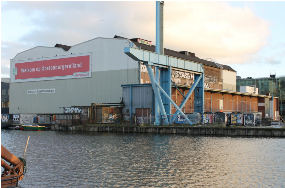
AFBEELDING 3: DE LANGHOUSHALLEN MET MODERNE BEPLATING, VOOR DE SLOOP VAN DE OMLIGGENDE BEBOUWING EN JONGSTE HAL LINKS (KOOPMAN ET AL., 2015)
