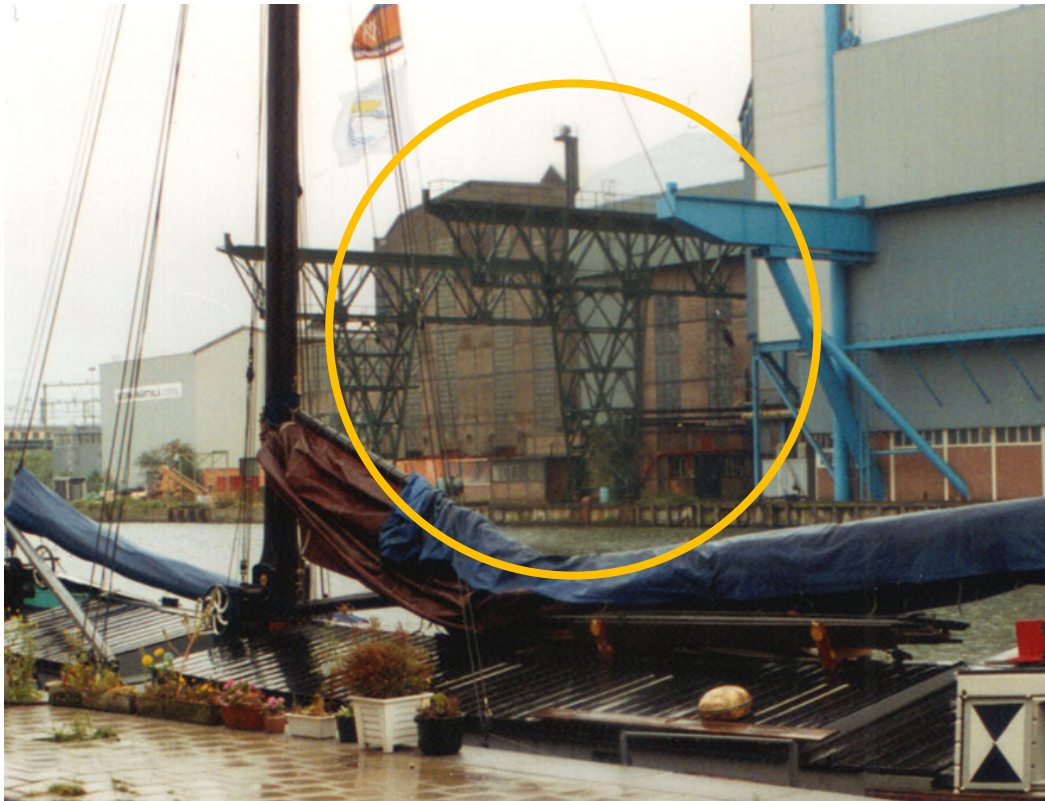
AFBEELDING 4: DE LANGHOUTHALLEN IN 1992, WAARBIJ DE KARAKTERISTIEKE, ORIGINELE BOUWMATERIALEN ZICHTBAAR ZIJN (DEKKER, 2016)
