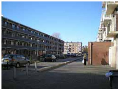
Nieuwbouw naast bestaande bouw
