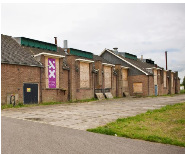
Afbeelding 5. De Veerensmederij, één van de gebouwen op de Wagenwerkplaats. Vóór transformatie
