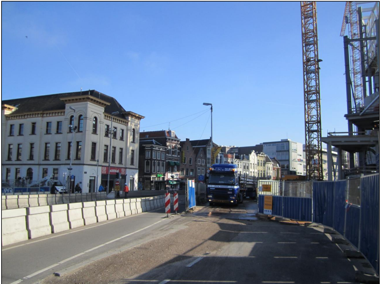
Figuur 1.1 Bouwlogistieke uitdaging muziekpaleis Utrecht (foto: B.Prinsen)
