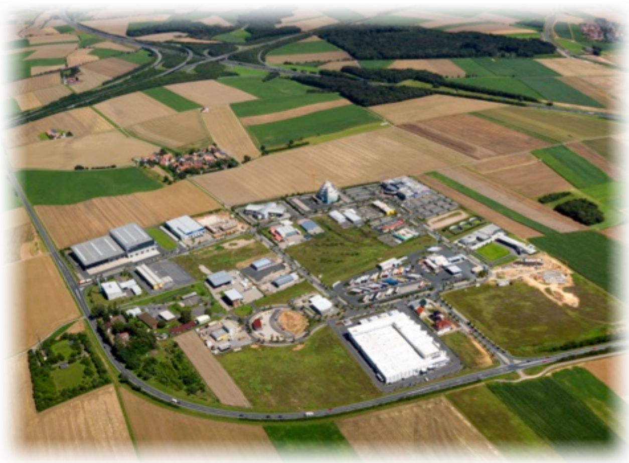
Figuur 3.4: Luchtfoto van het MainFrankenPark in Dettelbach, Beieren, Duitsland. (Gerhard Launer WFL-GmbH, Rottendorf, 2008)
