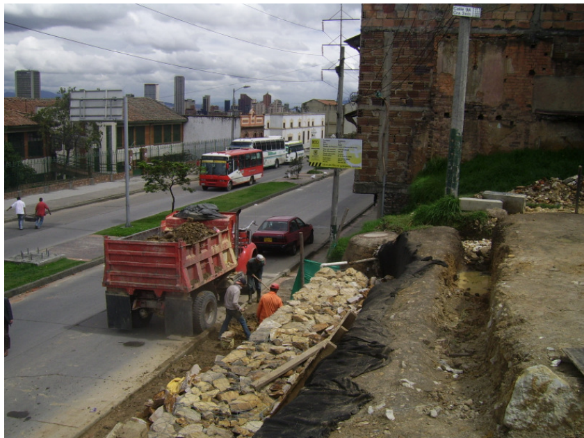
Fig. 8: Foto van het projectgebied tijdens interventie (beschikbaar gesteld door IDPAC)
