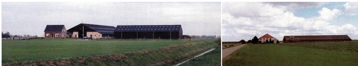
Bron: Wierde & Dijk (2003)
