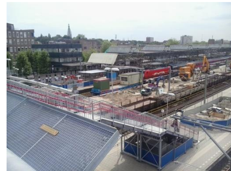
Figuur 20: Breda (bron: foto v.d. auteur)
