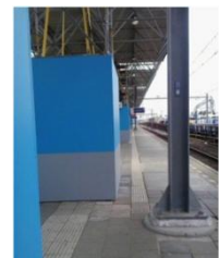
Figuur 23: Tijdelijke steunpilaar station Breda (bron: foto v.d. auteur)
