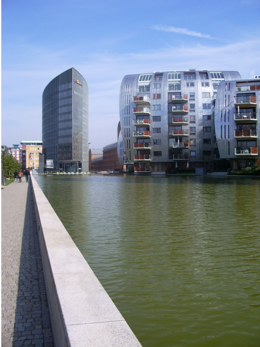
Afbeelding 3: Armada gebouwen Paleiskwartier, 's Hertogenbosch. Het Paleiskwartier wordt gekenmerkt door gesloten woonblokken die rond een centraal waterbassin zijn aangelegd.
