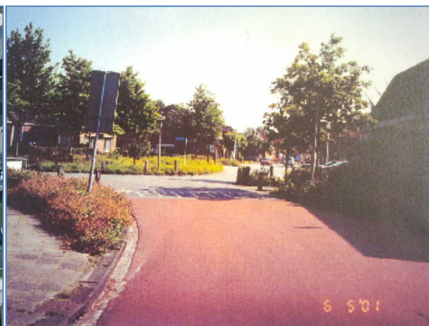
Figuur 58: Oostenburgplein voor reconstructie.
