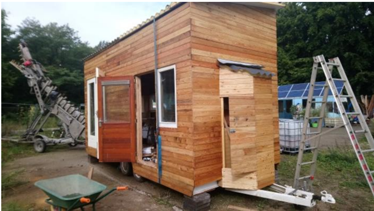
Afbeelding 5.6 Voorbeeld van een mobiel tiny house gebouwd op een trailer. (Bron: Judith Antonides, 2017)
