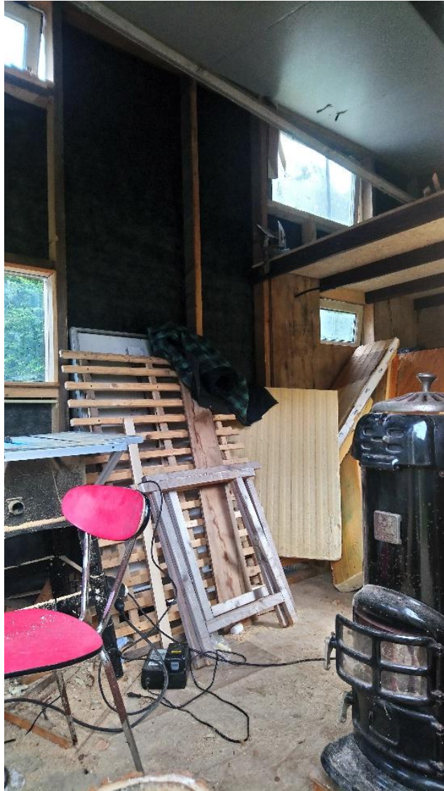
Afbeelding 5.12 Voorbeeld van een tiny house in aanbouw. (Bron: Judith Antonides, 2017)
