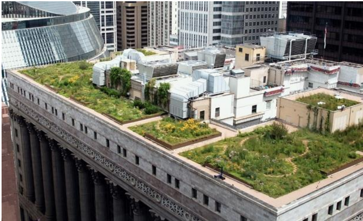
Figuur 5 Groene daken op de City Hall van Chicago. Door de planten vindt er meer evapotranspiratie plaats waardoor warmte wordt opgenomen. Daarnaast weerkaatsen de planten warmte beter dan de buitenkant van het materiaal van het gebouw. Bron: www.greenroofs.com geraadpleegd op 08-01-2019
