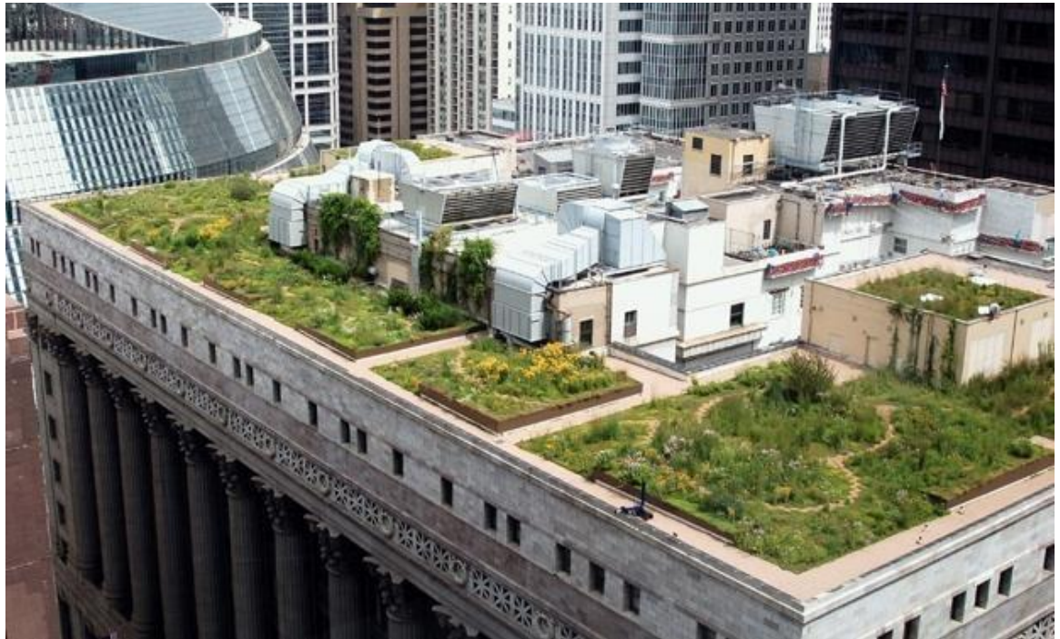
Figuur 4 Groene daken op de City Hall van Chicago. Door de planten vindt er meer evapotranspiratie plaats waardoor warmte wordt opgenomen. Daarnaast weerkaatsen de planten warmte beter dan de buitenkant van het materiaal van het gebouw. Bron: www.greenroofs.com
