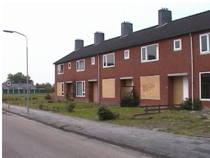
Figuur 2.2.1.c.: Foto leegstaande woningen
