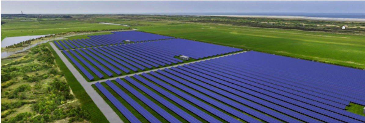
Figuur 1: Een impressie van het zonnepark op Ameland met linksonder de aangelegde strandwal
