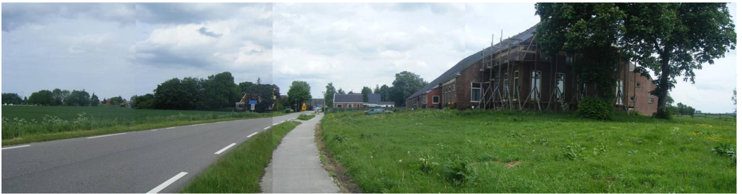
Fig. 3.4 Ingang vanaf de Verlengde hoofdweg (aangegeven in fig. 3.3 met A).
