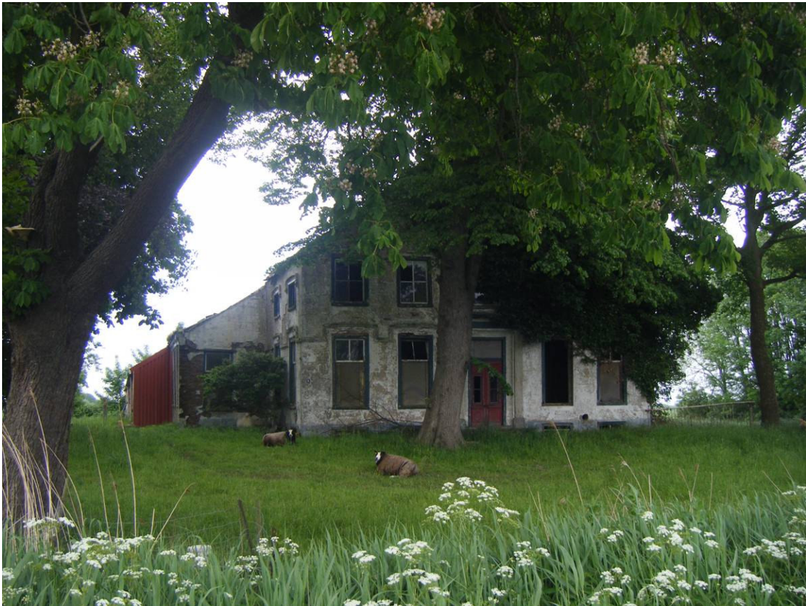
Fig. 4.20 Vervallen boerderij die wordt bewoond door schapen (bron: eigen collectie)
