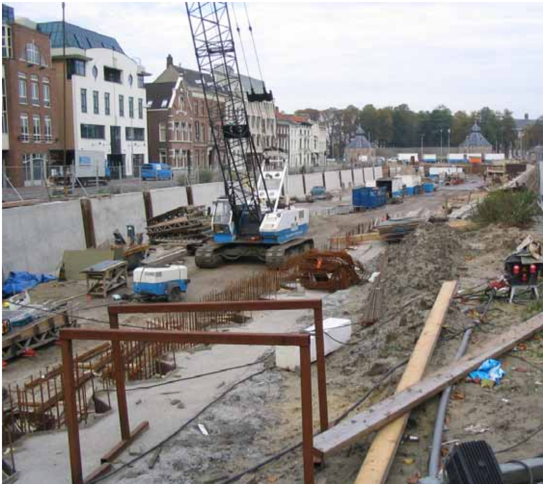
Afbeelding 3.6. Werkzaamheden aan de haven in Breda (eigen foto)
