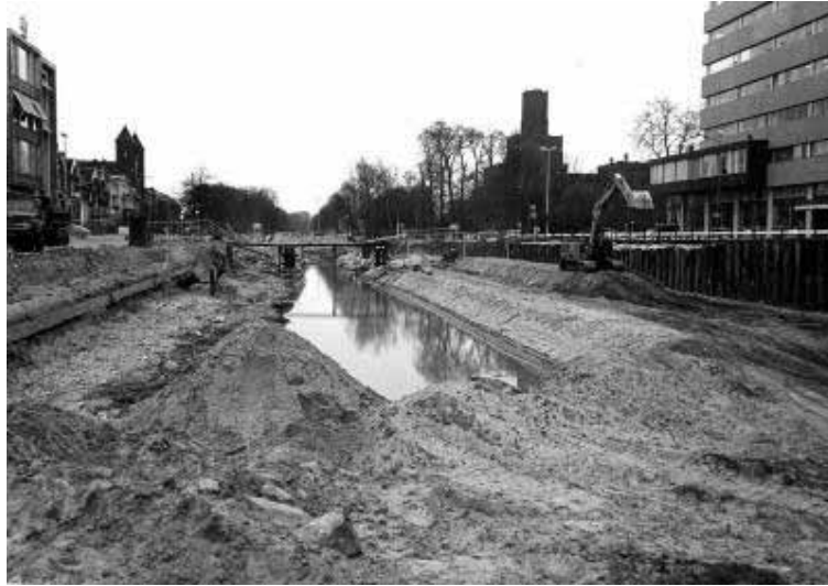
Afbeelding 5.3. Werkzaamheden demping van de Catharijnesingel, 1971, (Het Utrechts Archief)
