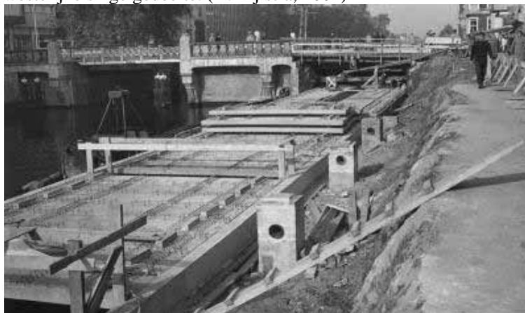
Afbeelding 5.2. Werkzaamheden demping van de Catharijnesingel, 1968, (Het Utrechts Archief)
