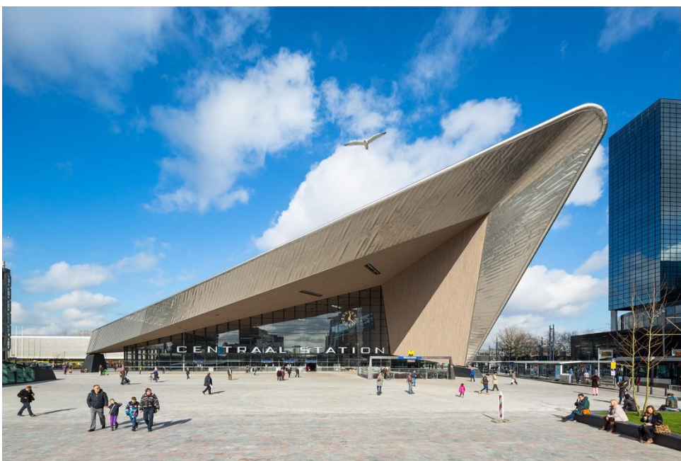
Figuur 10: vooraanzicht van station Rotterdam Centraal na de verbouwing. (gebouwt van het jaar, 2014)
