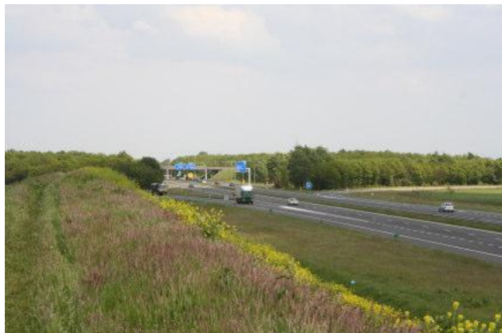
Figuur 2.1: Een geluidswal scheidt de A28 met de nieuwbouwwijk Erflanden in Hoogeveen (foto: Peter Hofman, 2010)
