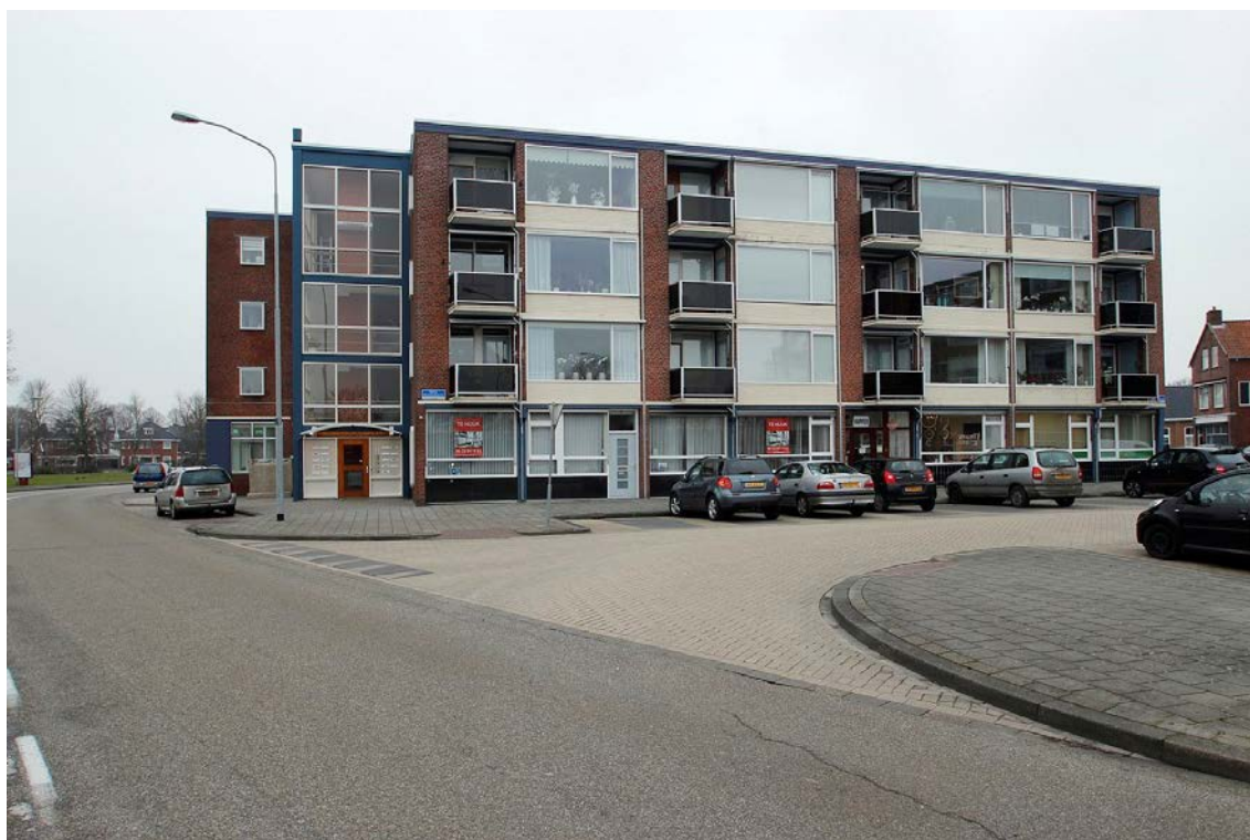
Figuur 13 – Object vraag 36 (appartementencomplex in Delfzijl)
