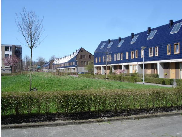
Figuur 5 De bejaardenwoningen in de stempels tussen de Kornalijnlaan en de Barnsteenstraat hebben plaatsgemaakt voor eengezinswoningen. Door een andere opzet te hanteren en centraal in de stempel een groen binnenterrein aan te leggen, versterkt het de herkenbaarheid binnen de buurt.
