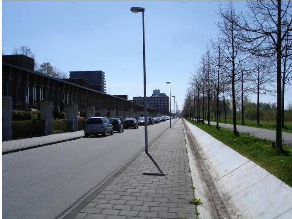
Figuur 4.5 De inrichting van de Kwartsstraat zorgt voor een duidelijke overgang tussen de bebouwing en de groen-blauwe Eelderbaanzone. Overtollige neerslag wordt opgevangen in de brede goot onder aan de promenade, wat ervoor zorgt dat het water in de wijk wordt gebracht. Foto: E. Heuff (2013)
