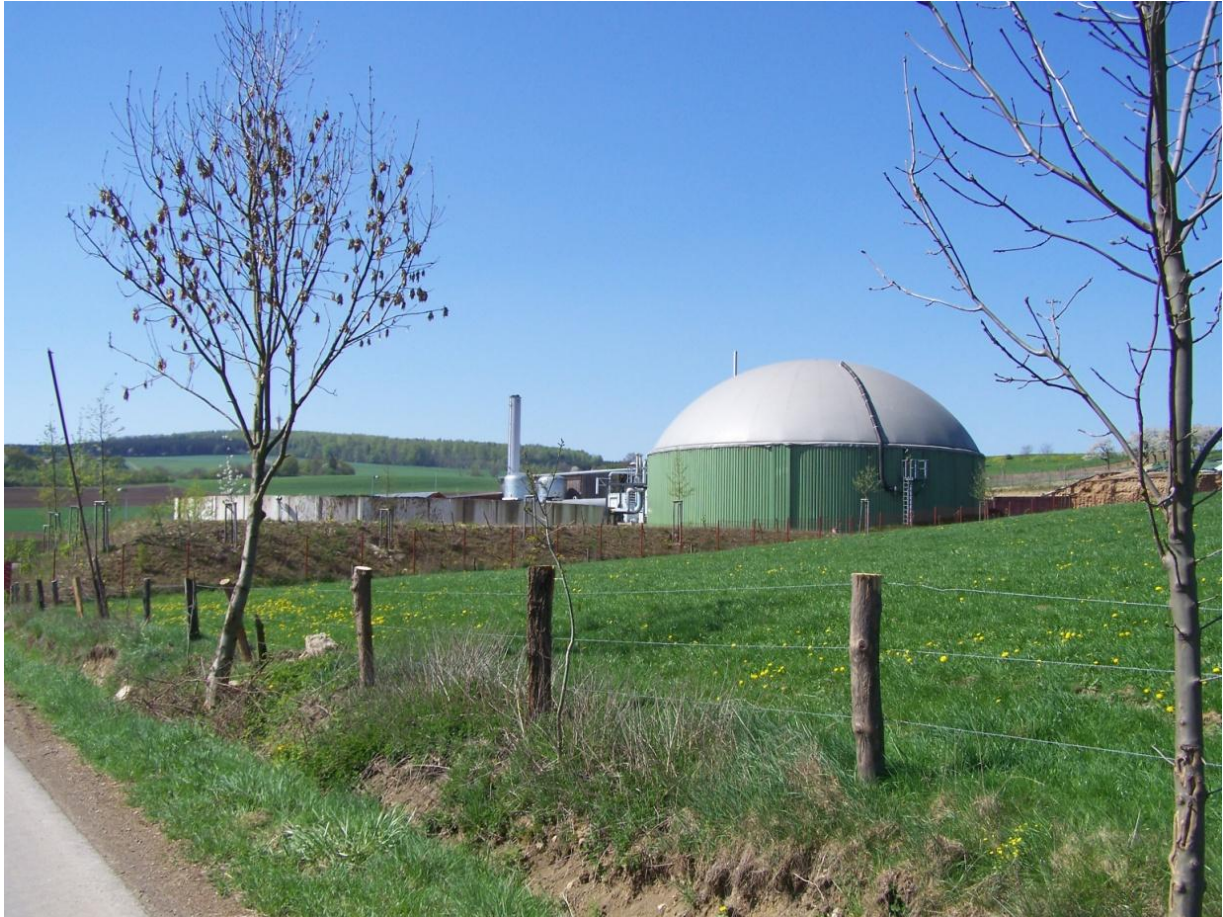
Figuur 4.1.4 Vergistingsinstallatie Jühnde
