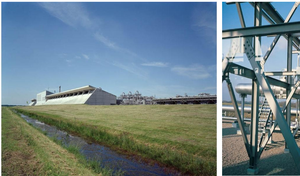
Figuur 4.6: Langelo; installatie achter het talud. (bron: bureau Alle Hosper, 2010)
