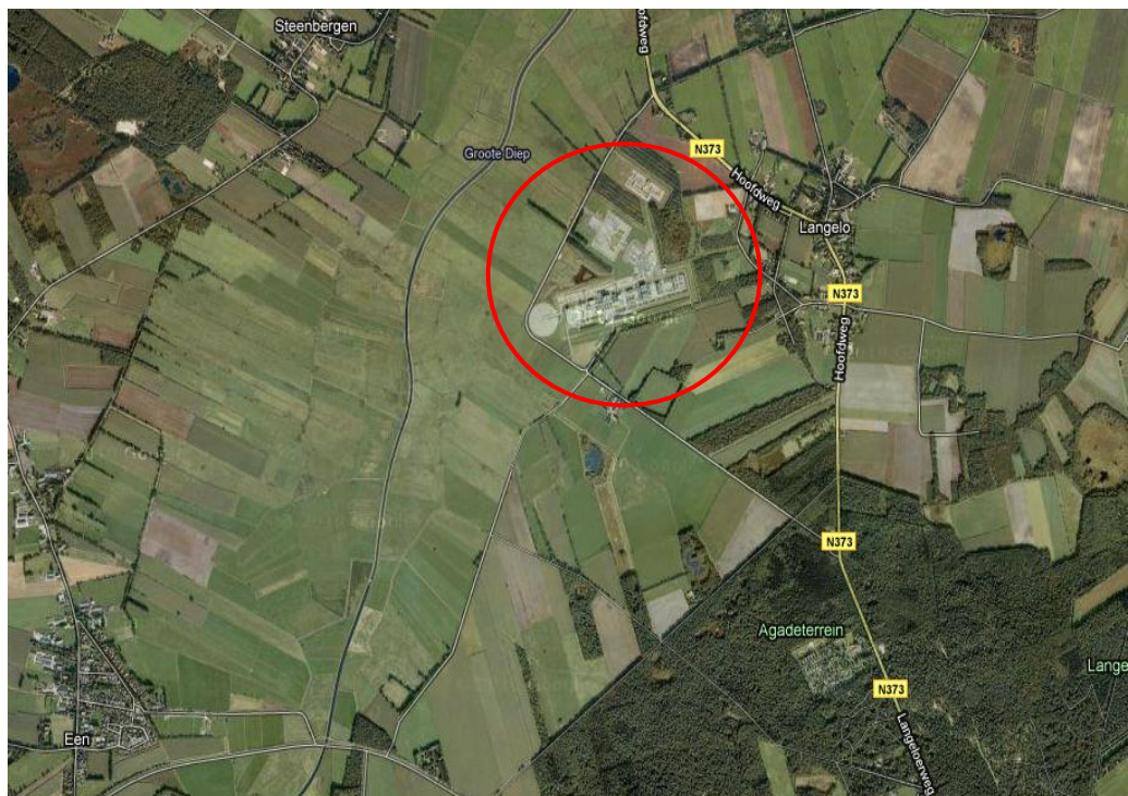
Figuur 4.3: Locatie gasopslaginstallatie Langelo, Norg. (bron: googlemaps.nl en gemeente Noordenveld)
