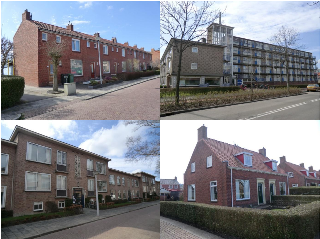
Figuur 3: de vier genomen foto's, zie bijlagen 2 tot en met 5 voor grotere afbeeldingen (met de klok mee: Rijtjeshuizen P. Waijerstraat, galerijflat Friesestraatweg, twee-onder-één-kapwoningen Stadsweg en portiekwoningen Scheldestraat / Merwedestraat). Bron: Terpstra (2013)
