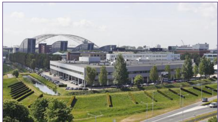
Afbeelding 3: Rivium Business Centre (DTZ Zadelhoff – 2012)
