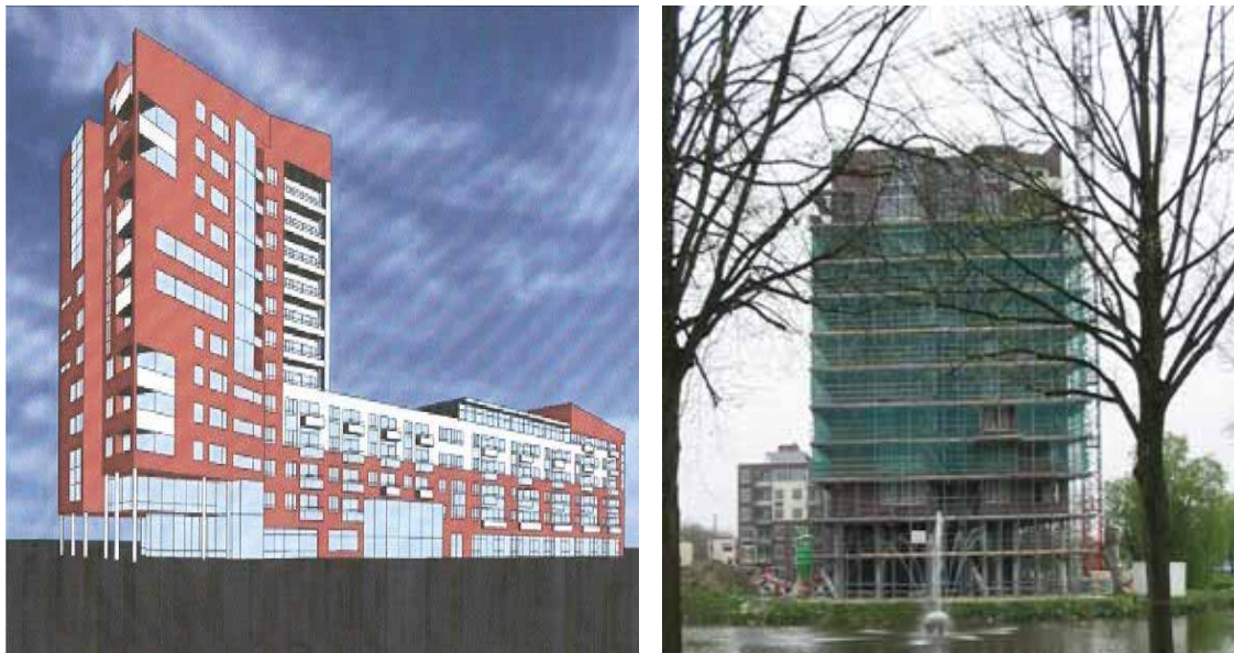
Figuur 11: Woonzorgcomplex op de plek van het gesloopte Wavingebouw (links, bron: DeltaWonen, 2004)
